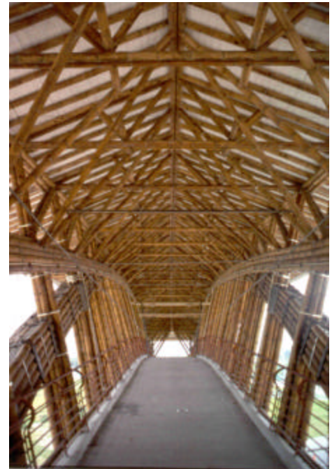
Puente peatonal cubierto, 45 m luz. Bogotá, Colombia Estructura de caña guadua y bambú Arq. Simón Vélez
