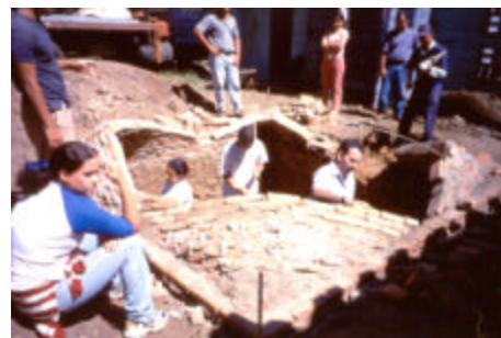
Técnica de construcción de cubiertas de ladrillo recargado. Sistema mexicano. Apropiación del conocimiento práctico, por estudiantes de la U. Central de Venezuela.
