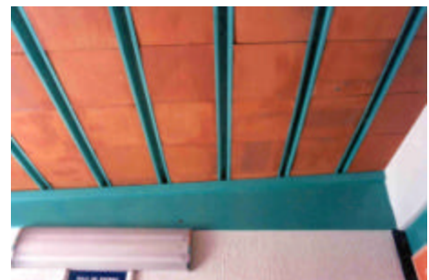
Bóveda tabicada en tres capas, en Extremadura, España
