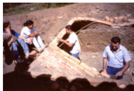
Técnica de construcción de cubiertas de ladrillo recargado. Sistema mexicano. Apropiación del conocimiento práctico, por estudiantes de la U. Central de Venezuela.
