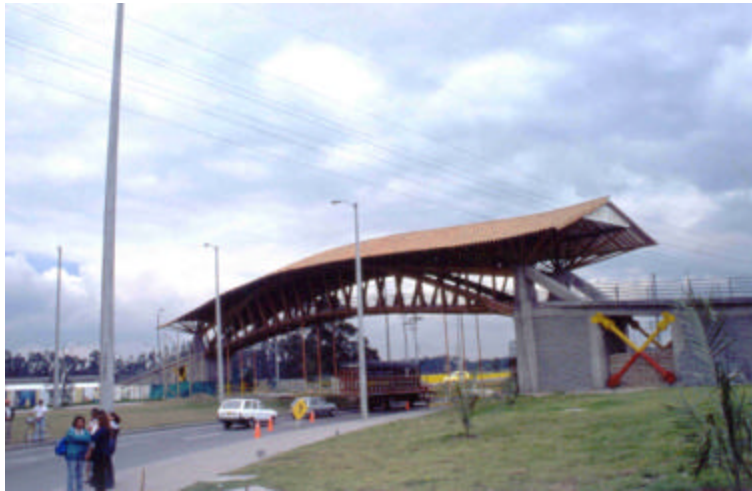
Puente peatonal cubierto, 45 m luz. Bogotá, Colombia Estructura de caña guadua y bambú Arq. Simón Vélez
