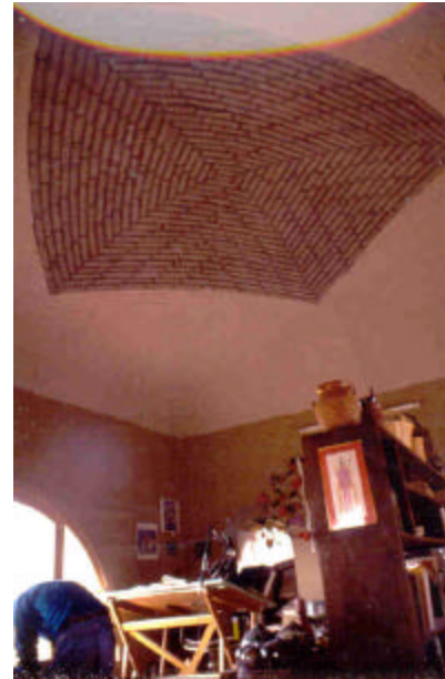
Bóveda de 5x5 m en adobe con las mismas dimensiones del ladrillo egipcio. (Obra del arquitecto Ferro, realizada por Ignacio Dorantes.)
