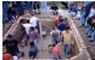
Bóveda en el campo experimental “El Laurel”. El nivel de la excavación es de 1 m bajo el nivel del terreno. Se colocan varillas en forma de arco en ambas diagonales para guiar la altura de los conos salidos de cada esquina. (U. Central de Caracas, Venezuela. 1998).
