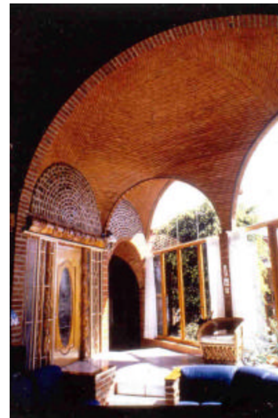
Esquema de bóvedas sobre plantas cuadradas, triangulares y trapezoidales, sobre arcos de medio punto como directrices. (Casa habitación en Cuernavaca, Morelos. 1989). Bovedero Manuel Perrusquía.
