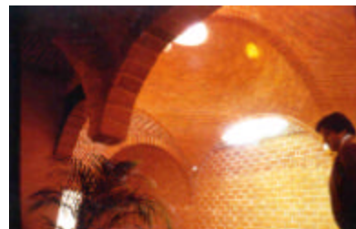
Unión de dos cúpulas bizantinas con columna hacia arriba a tracción. En su unión las directrices son dos ángulos comerciales de 2"x2"x1/8" pegados de espalda. Y en este caso recubiertos con ladrillo. (Clínica Popular en La Villa, D. F. 1992 y 1998).
