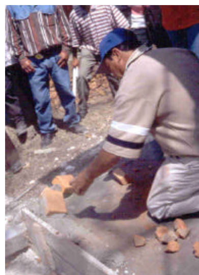
El tercer pedazo es menor que los dos laterales y se coloca a manera de la clave del arco.
