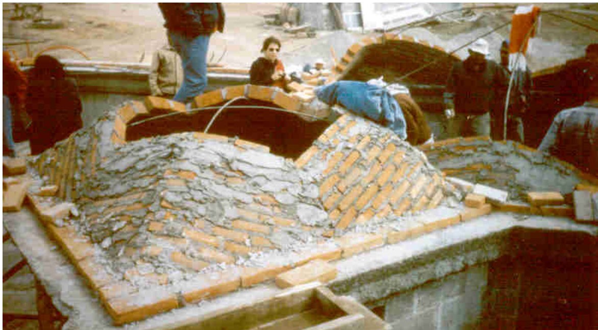
Esta bóveda fue realizada sin la participación del artesano. Aquí se muestran las indicaciones para el arranque de la bóveda. El primer ladrillo cortado a la mitad y colocado en un ángulo de 45 grados. La primera hilada constituida por tres pedazos de ladrillo y la segunda se inicia con piezas completas en los extremos y un ajuste en el centro. Como guía se coloca una hilada sobre la cadena de concreto. (Bóvedas en cafetería de la U. La Salle de Pachuca, Hidalgo. 1997).
