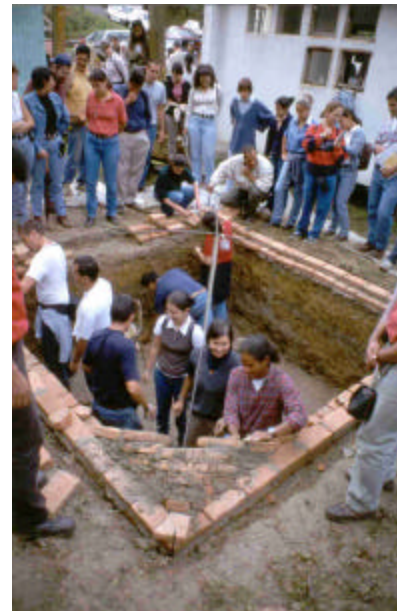
Bóveda en el campo experimental “El Laurel”. El nivel de la excavación es de 1 m bajo el nivel del terreno. Se colocan varillas en forma de arco en ambas diagonales para guiar la altura de los conos salidos de cada esquina. (U. Central de Caracas, Venezuela. 1998).
