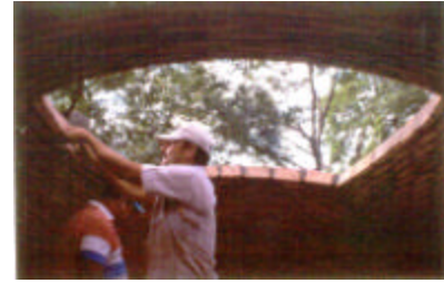
Vista interior del proceso de cierre. Nótese la tendencia a la verticalidad del ladrillo, conforme se acerca al punto más alto. El artesano es colombiano y fue su primera experiencia en esta técnica. (Bóveda en parque infantil recreativo, Cúcuta, Colombia. 1997)
