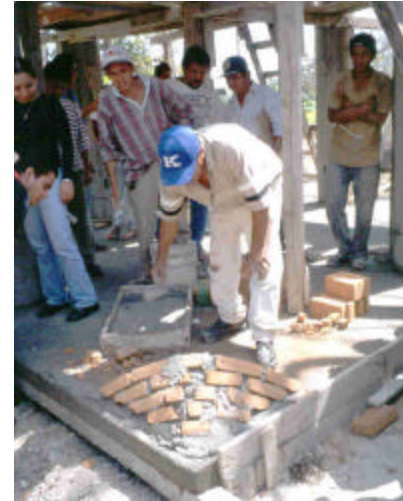
Para que el grupo de 60 personas asistentes al taller, pudiera observar el inicio de la construcción de la bóveda, el maestro Ignacio Dorantes, realizó los pasos del arranque a nivel de piso. (Bóveda en vestíbulo de Auditorio. U. A. de Chiapas, Tuxtla Gutiérrez. 2000.)
