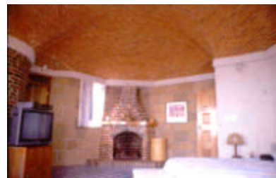
Directrices poligonales irregulares. (Casa habitación en Cuernavaca, Morelos. 1989). Bovedero Manuel Perrusquia.
