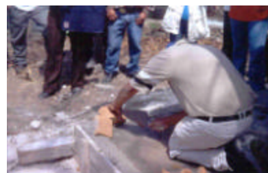
2°. Paso. Se inicia la primer hilada. Se pueden poner solamente 2 ladrillos; en vez de un arco, la hilada queda en forma de “A”. Ignacio Dorantes que es perfeccionista, prefiere colocar 3 pedazos de ladrillo para que se forme el primer arco poligonal.
