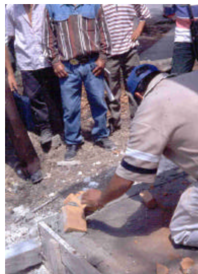
El tercer pedazo es menor que los dos laterales y se coloca a manera de la clave del arco.
