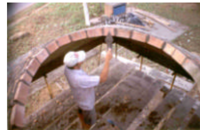
Vista exterior del proceso de cierre en el momento de la unión de los cuatro mantos. La foto está tomada en el mismo momento que la anterior. (Bóveda en parque infantil recreativo, Cúcuta, Colombia. 1997)
