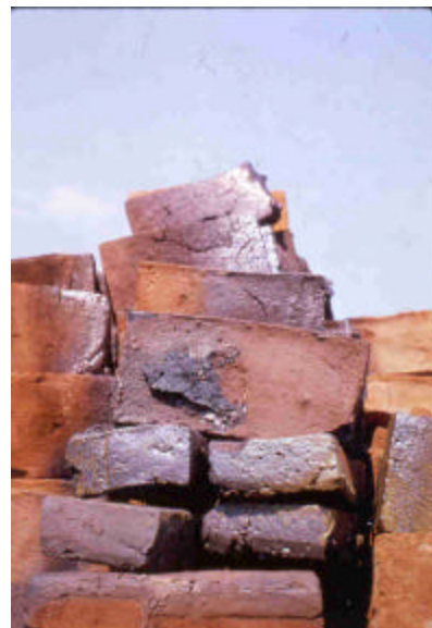
Ladrillo cocido en exceso. En México se llama recocho. El alto grado de cocción, lo vitrifica e incrementa su resistencia.
