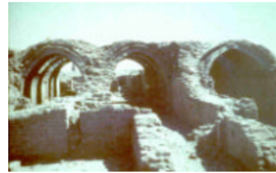
La cubierta consta de varias capas de adobe (5x15x25 cm). Los arcos cubren pequeños claros. (Ramesseum).
