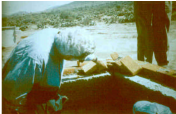
Esta bóveda fue realizada sin la participación del artesano. Aquí se muestran las indicaciones para el arranque de la bóveda. El primer ladrillo cortado a la mitad y colocado en un ángulo de 45 grados. La primera hilada constituida por tres pedazos de ladrillo y la segunda se inicia con piezas completas en los extremos y un ajuste en el centro. Como guía se coloca una hilada sobre la cadena de concreto. (Bóvedas en cafetería de la U. La Salle de Pachuca, Hidalgo. 1997).
